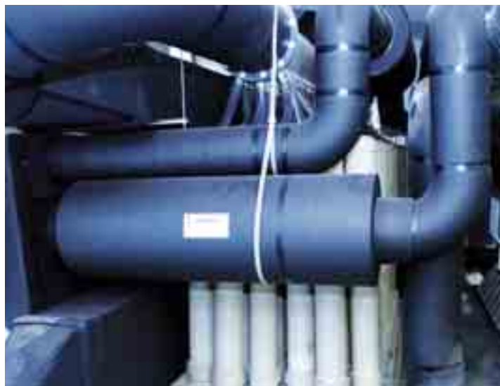
Op de ventilatie- en koelinstallaties van de Drukkerij werden geluidsdempers geplaatst.
